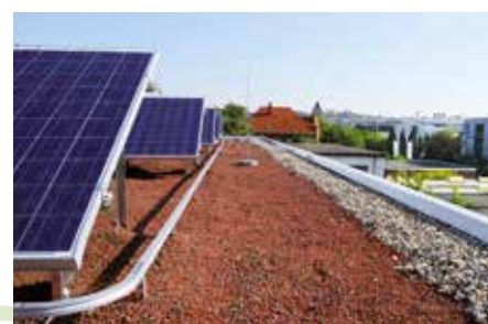
Dachdurchdringungsfreier Einbau, da die nötige Auflast lediglich mit Zincolit® bzw. Systemerde oder alternativem Schüttgut erbracht wird.
